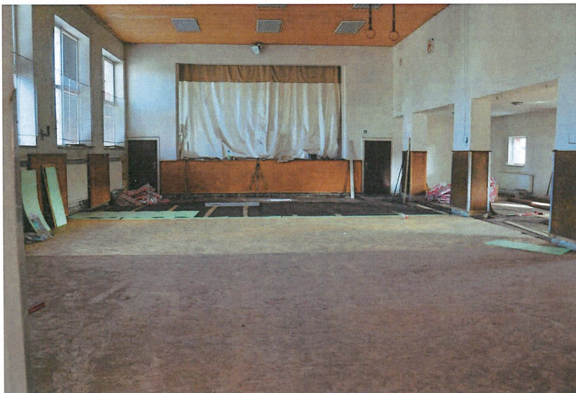
Obr. č. 6 – vnitřní prostor sokolovny – nyní v rekonstrukci
